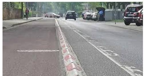
zung des Grünstreifens gewonnen werden. Auch für diesen Vorschlag sind nur kleine Baumaßnahmen notwendig: Entfernen der Verkehrsinsel, Asphaltstreifen von 40 m Länge und 0,7 m Breite. Darüber hinaus sind nur Ummarkierungsarbeiten und das Aufbringen der HfM-Markierung zu leisten.
